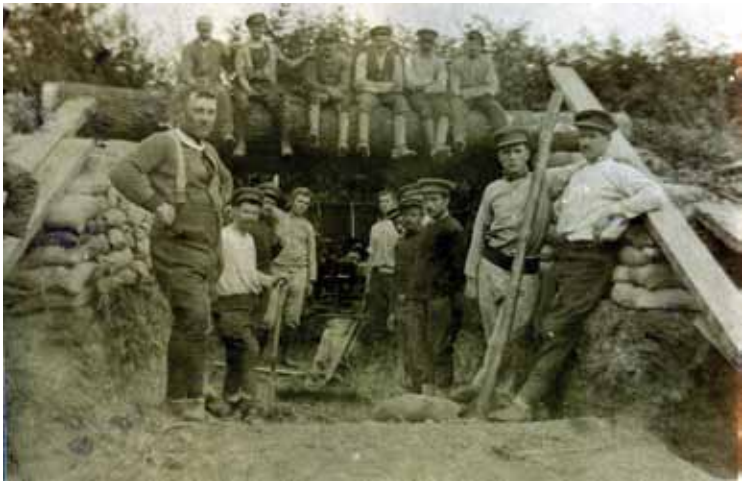
Construction d'un abri pour canons
