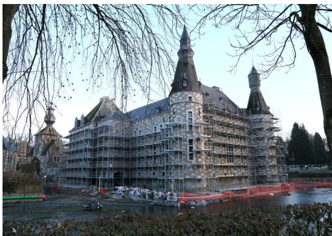
Château de Jehay Placement d'un échafaudage en vue de la restauration
