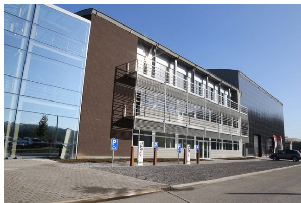
Seraing – Phase 3 de la Maison de la Formation
