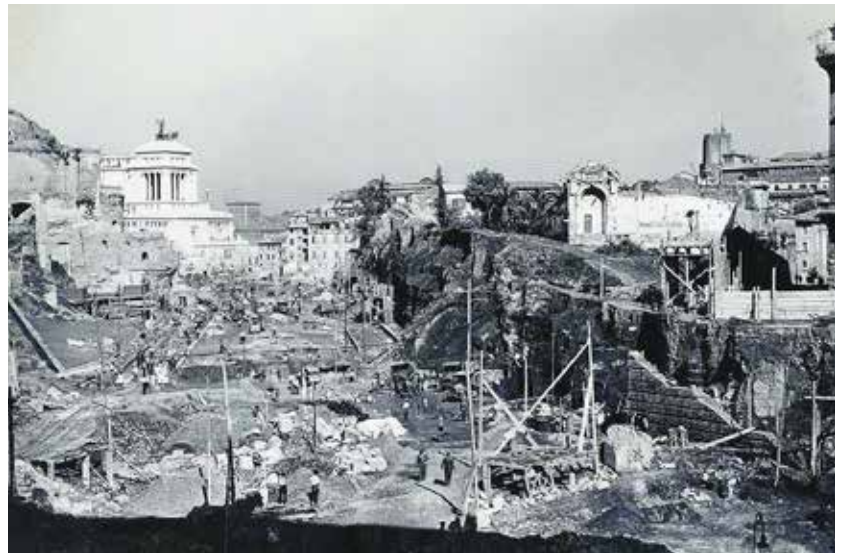
Travaux sur la future Via dei Fori imperiali
