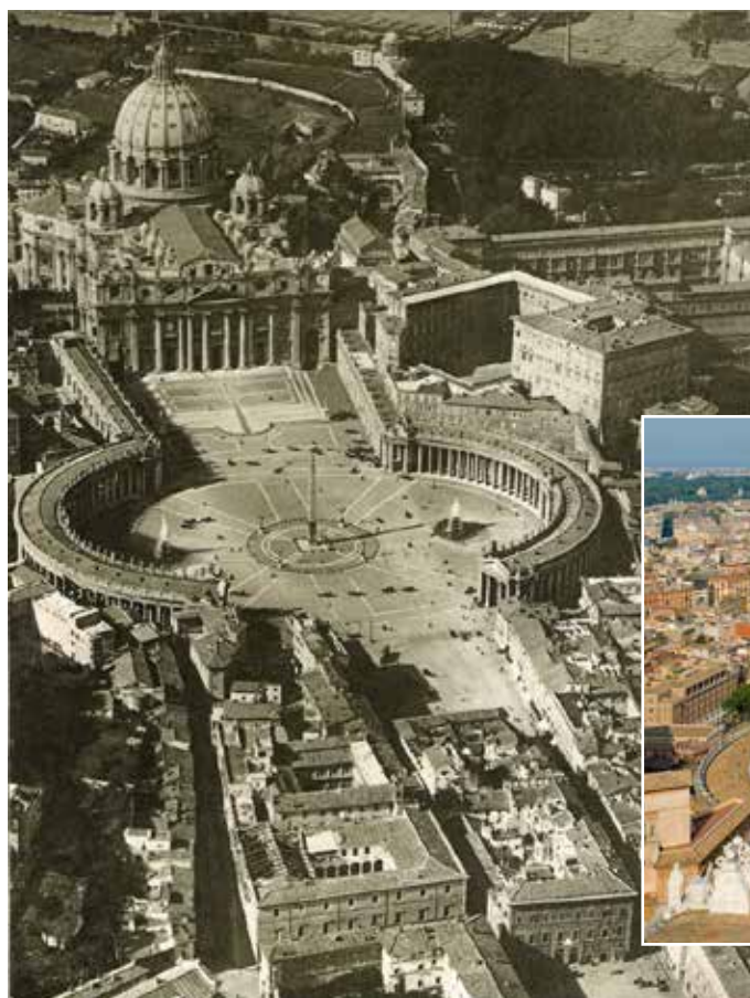
La Place Saint-Pierre avant les travaux de 1936
