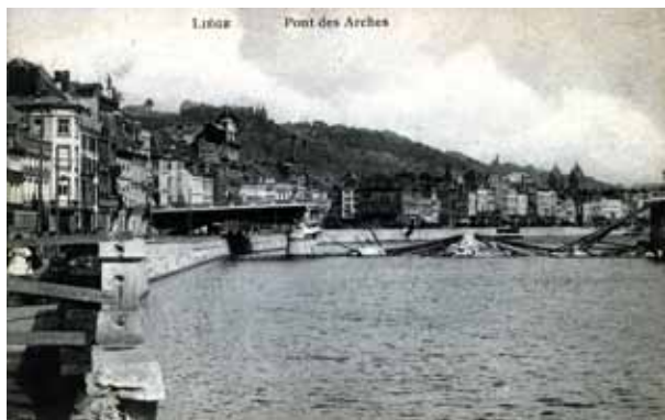
Le pont des Arches, Liège
