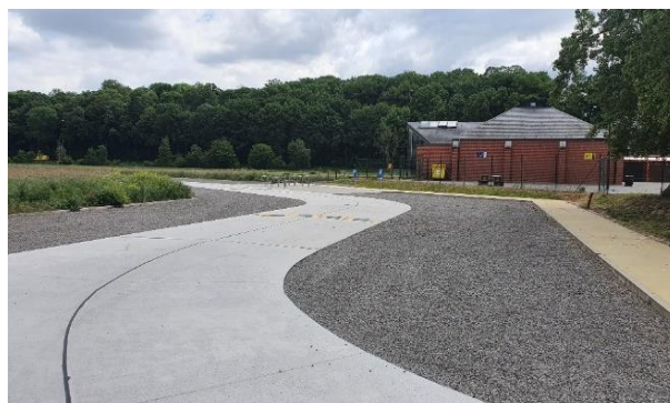
BRAIVES - Parking d'Ecovoiturage de Fallais
