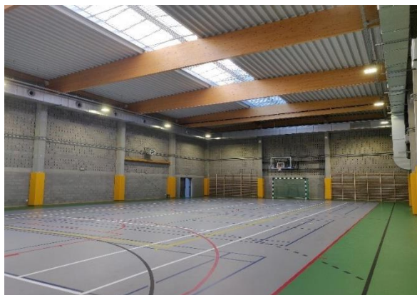
Hall de sports IPES Micheroux - intérieur
