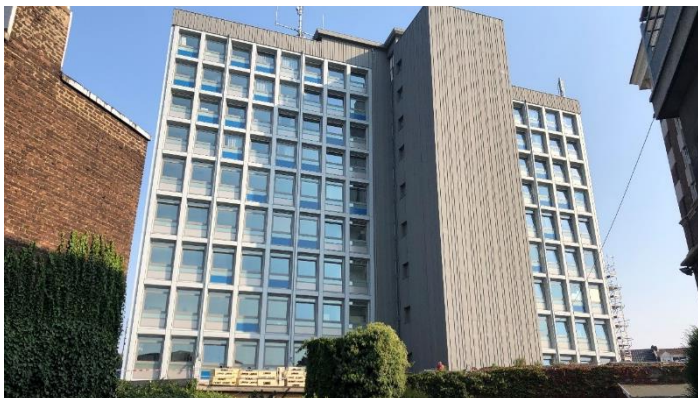
Internat de Seraing Vue de la façade après rénovation
