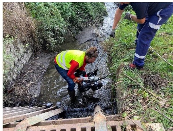
Essais de levés de canalisations via des caméras sur robots motorisés
