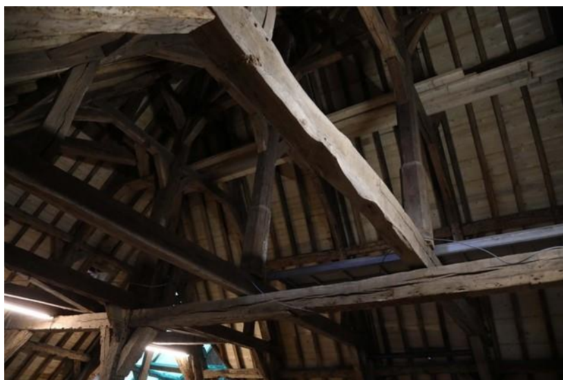
Château de Jehay -Vue intérieure de la charpente du 16e siècle restaurée
