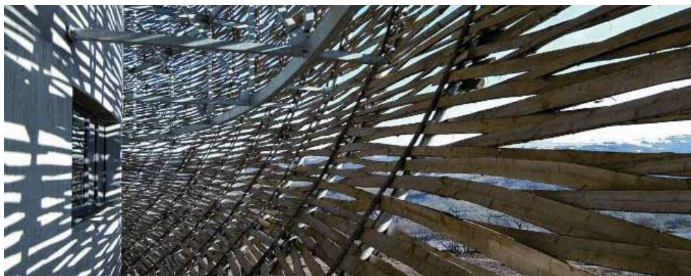
Architecte - Atelier 4 Projet - Scénoparc 10 Tressage de bois de châtaignier de l'enveloppe (détail) © Christophe Camus.
