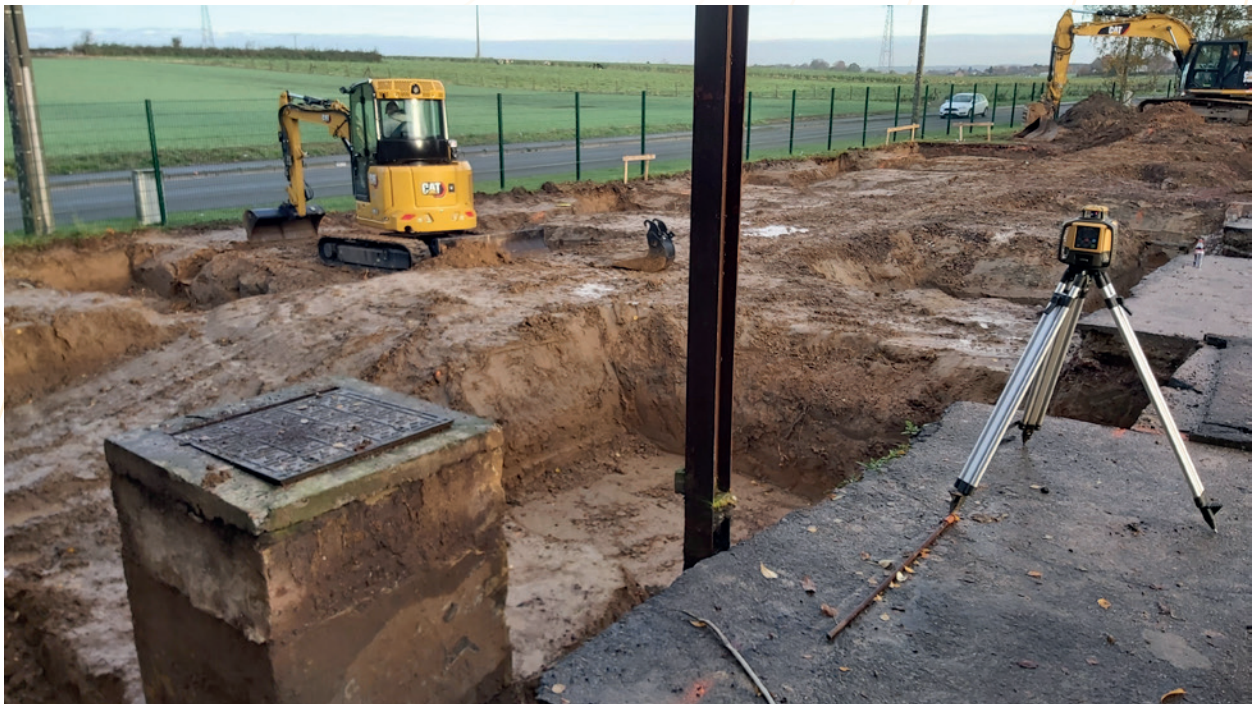
Travaux extérieurs CTL
