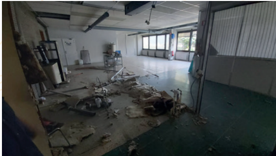
Travaux intérieurs CTL
