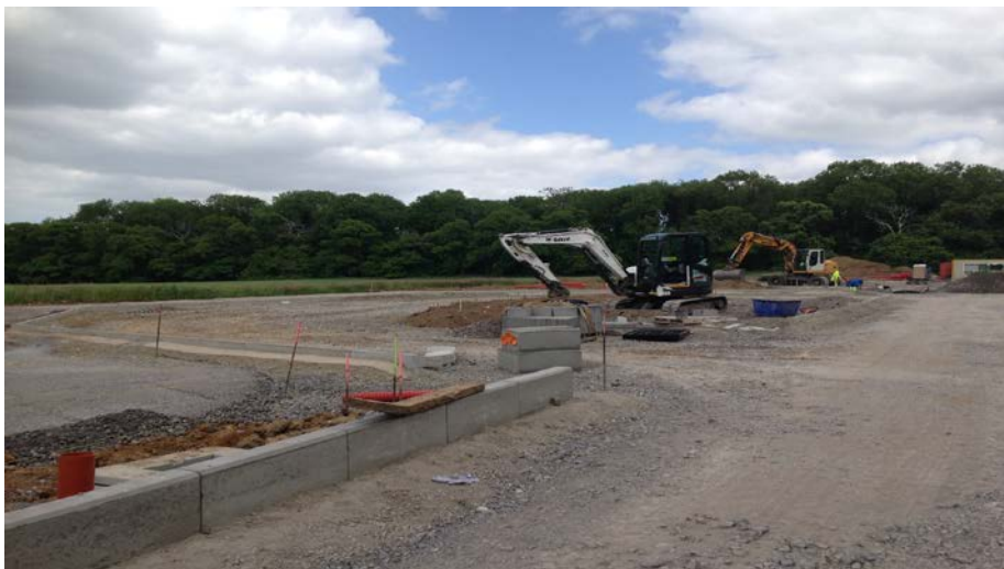
Entrée du parking visiteurs en cours de finalisation
