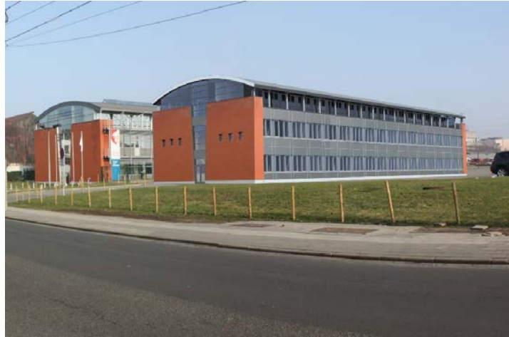
Maison de la Formation - phase 2
