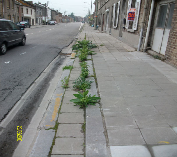
Entretien de trottoir
