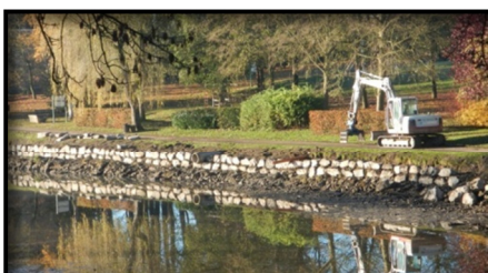
Stabilisation et aménagement des berges des étangs
