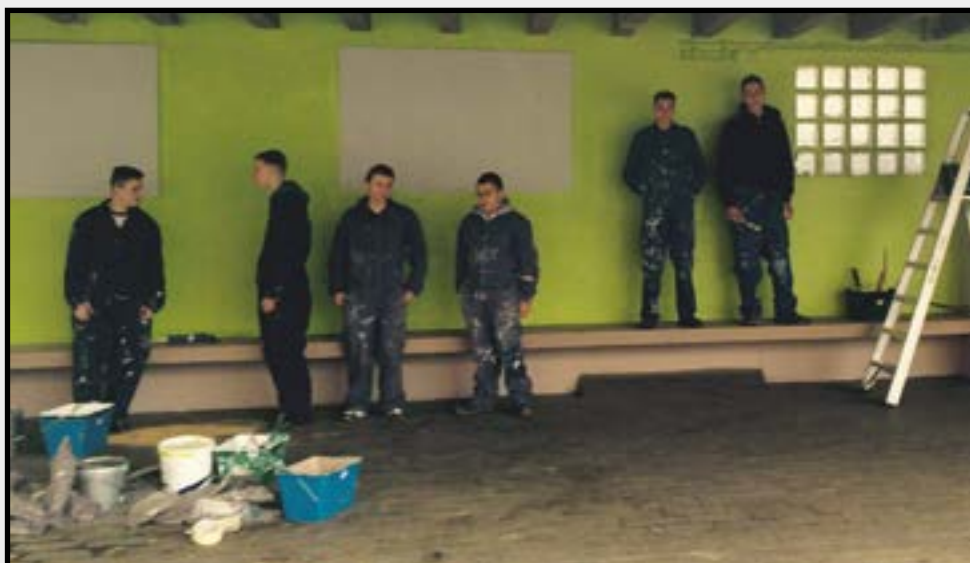
Le préau de l'EP Herstal en cours de rénovation par les élèves du CEFA
